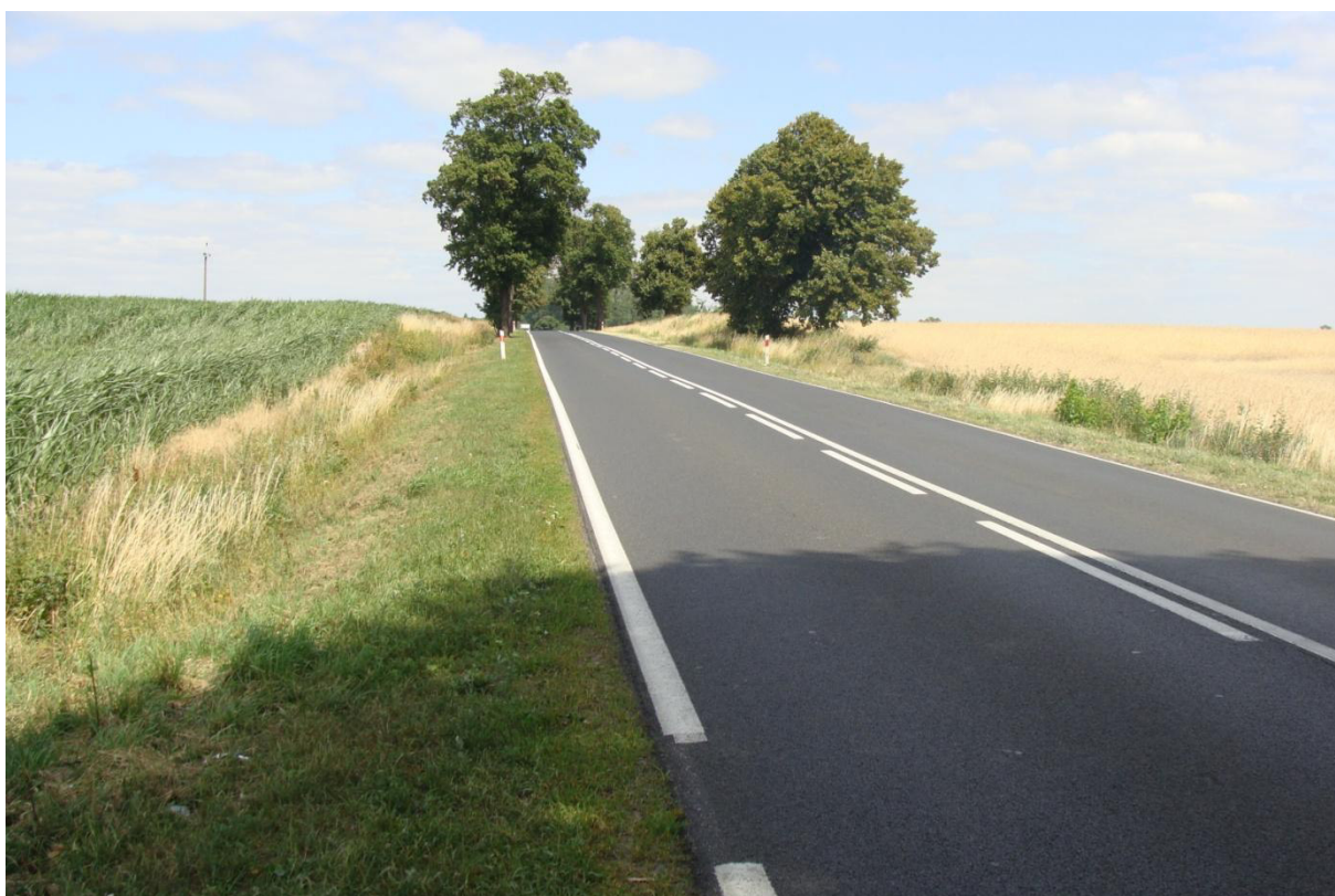
FOT. NR 2 KM 0+000 PROJ. OBWODNICY DW 241 Marlewo
