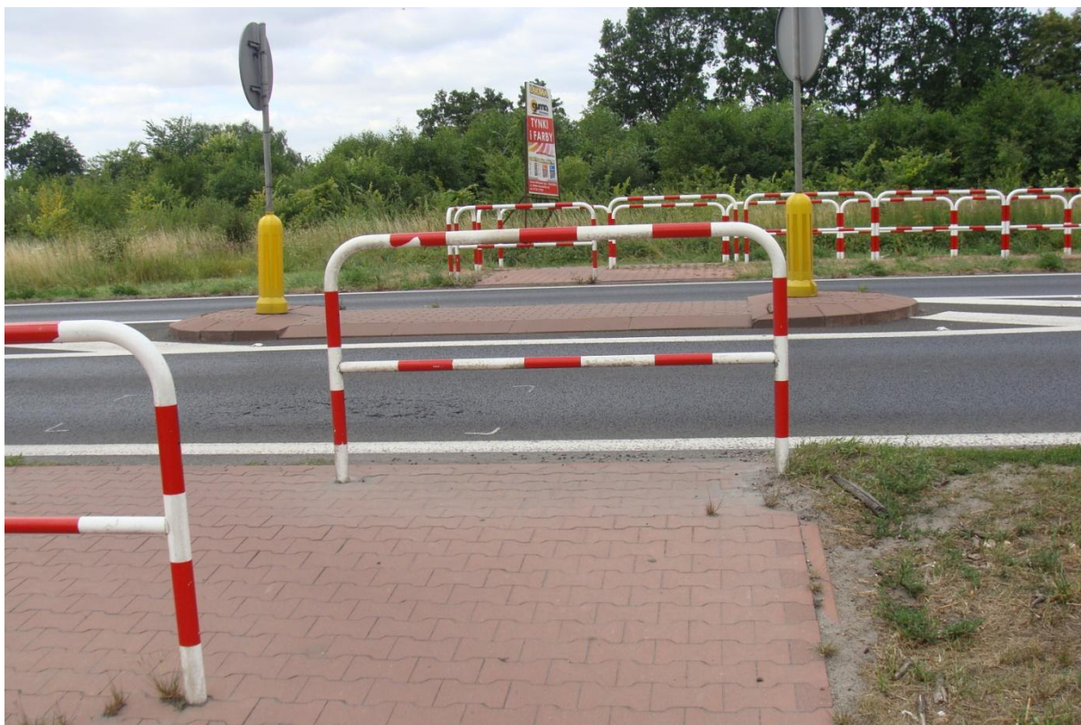
FOT. NR 26 KM 7+100 PROJ. OBWODNICY DK11
