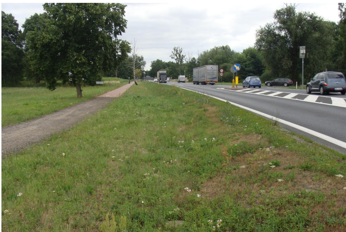
FOT. NR 22 KM 7+100 PROJ. OBWODNICY DK11
