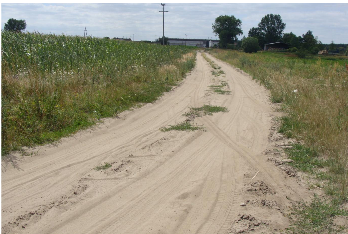
FOT. NR 4 KM 1+550 PROJ. OBWODNICY DG 272516P
