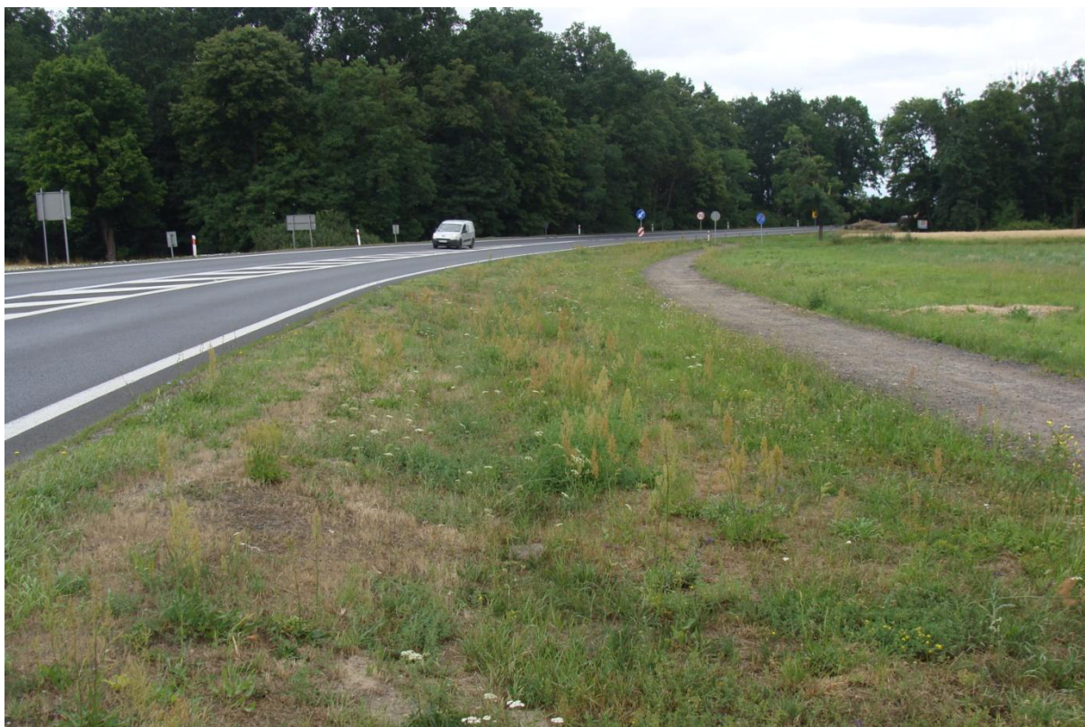
FOT. NR 23 KM 7+100 PROJ OBWODNICY DK11
