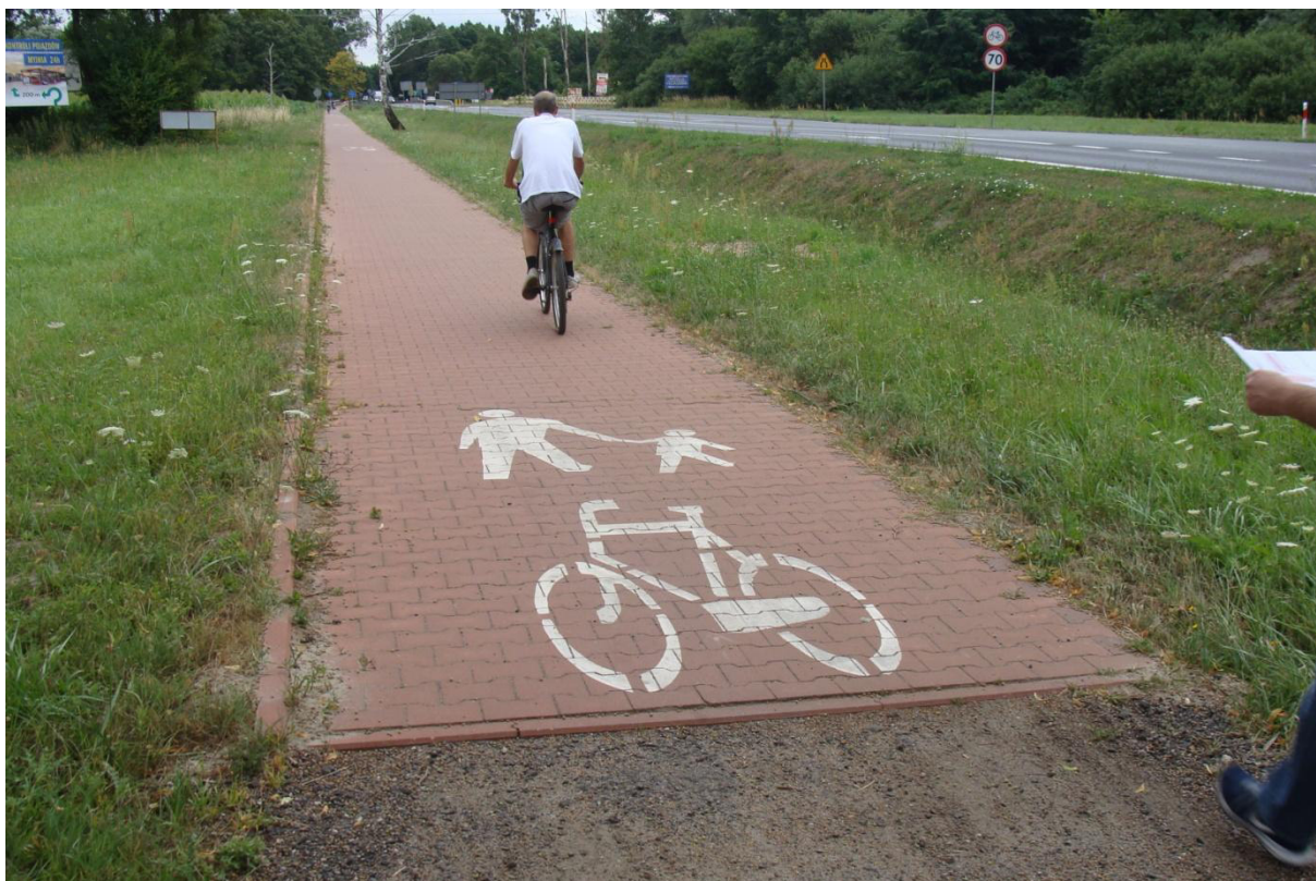
FOT. NR 24 KM 7+100 PROJ. OBWODNICY DK11
