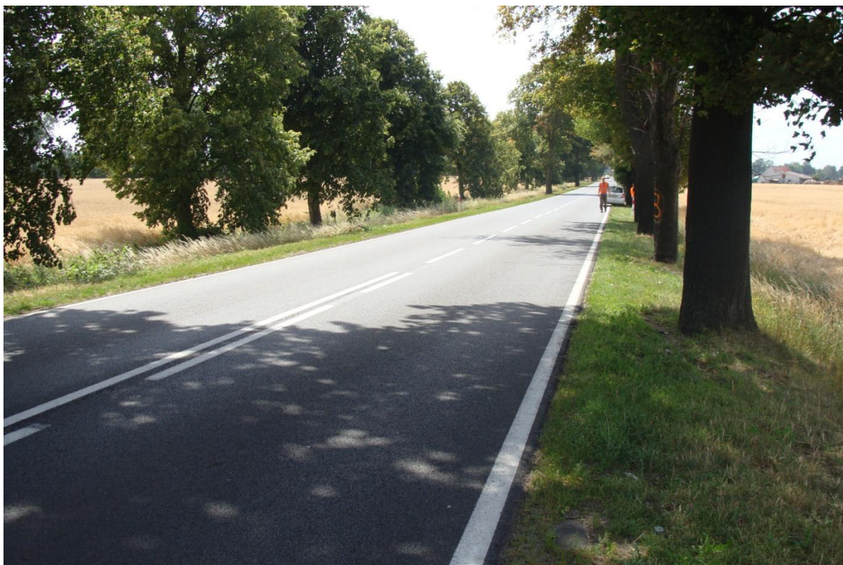
FOT. NR 1 KM 0+000 PROJ OBWODNICY DW 241 Marlewo
