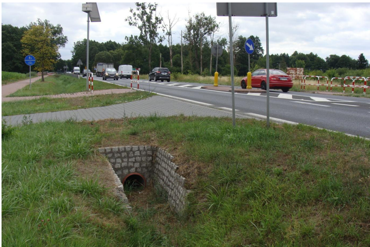
FOT. NR 25 KM 7+100 PROJ OBWODNICY DK11
