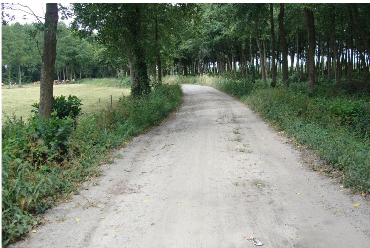
FOT. NR 12 KM 3+620 PROJ. OBWODNICY DG nr 272515P
