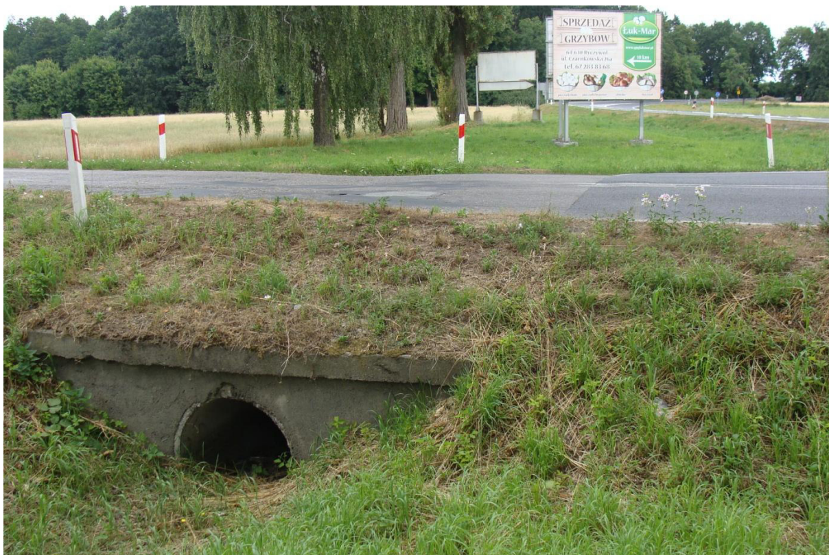
FOT. NR 21 KM 7+100 PROJ. OBWODNICY DP 1325P
