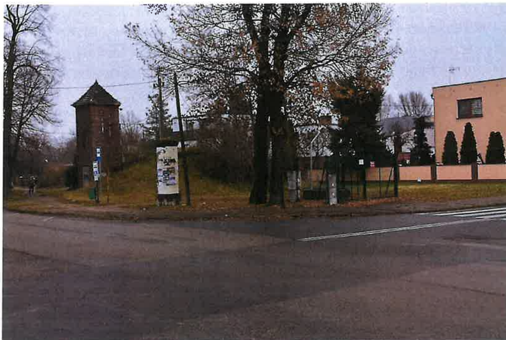
Fotografia 19 Teren zieleni w Rogoźnie przy ul. Dworcowej
